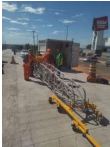
Figura 6 – Equipamento Perfilógrafo Califórnia.
