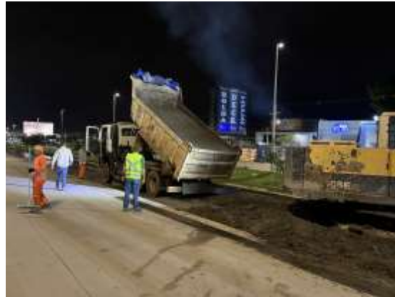
Figura 5 - Transporte do concreto em caminhões basculante.
