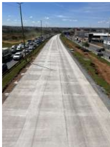
Figura 7 – Visão geral do pavimento de concreto Whitetopping - Pista Sul.
