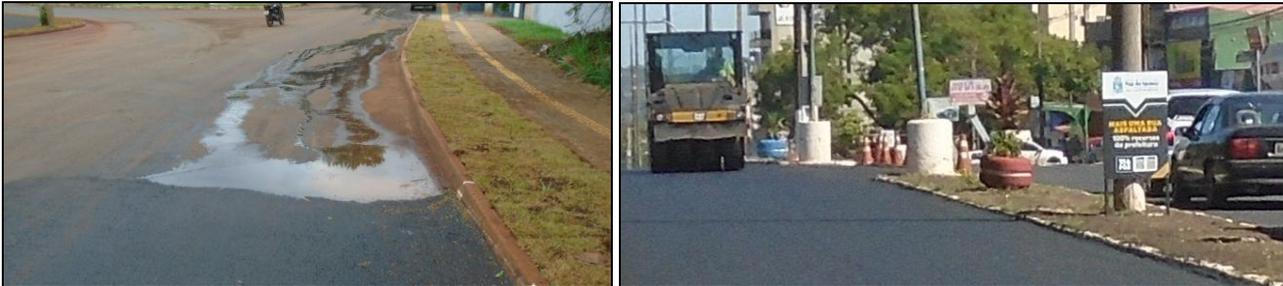
Figura 1. Problema de drenagem superficial pela inexecução de fresagem antes da aplicação do novo revestimento (encobrimento de sarjeta e limitação de guias) (DOBES, 2023).
