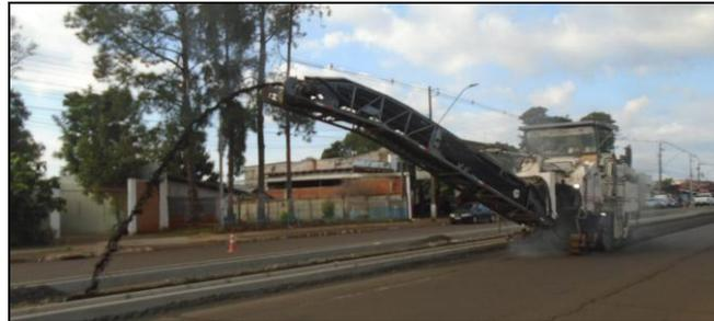
Figura 3. Equipamento de fresagem de médio porte utilizado no município (DOBES, 2023).
