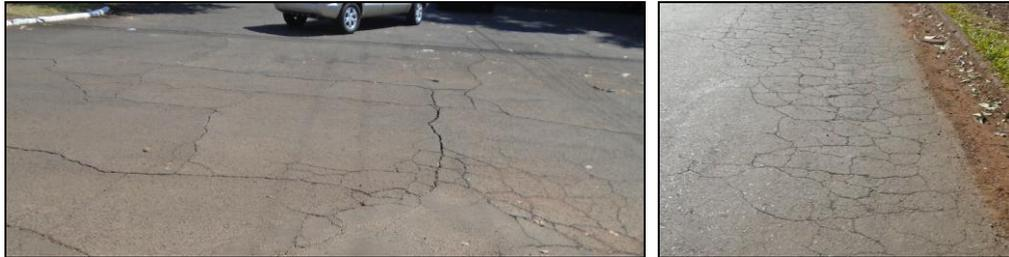
Figura 2. Manifestações patológicas de revestimento que necessitam da devida solução antes da aplicação da nova capa asfáltica (DOBES, 2023).
