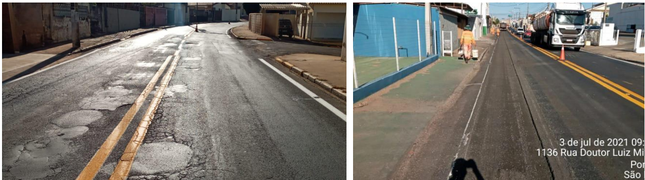
Figura 2 Ilustração da condição da superfície do pavimento antes da execução da restauração com EME
