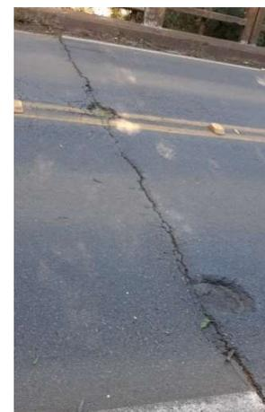
Fotografia 3- a) Trinca longitudinal, b) Trinca longitudinal - ampliação, c) Patologias presentes na cabeceira da ponte
