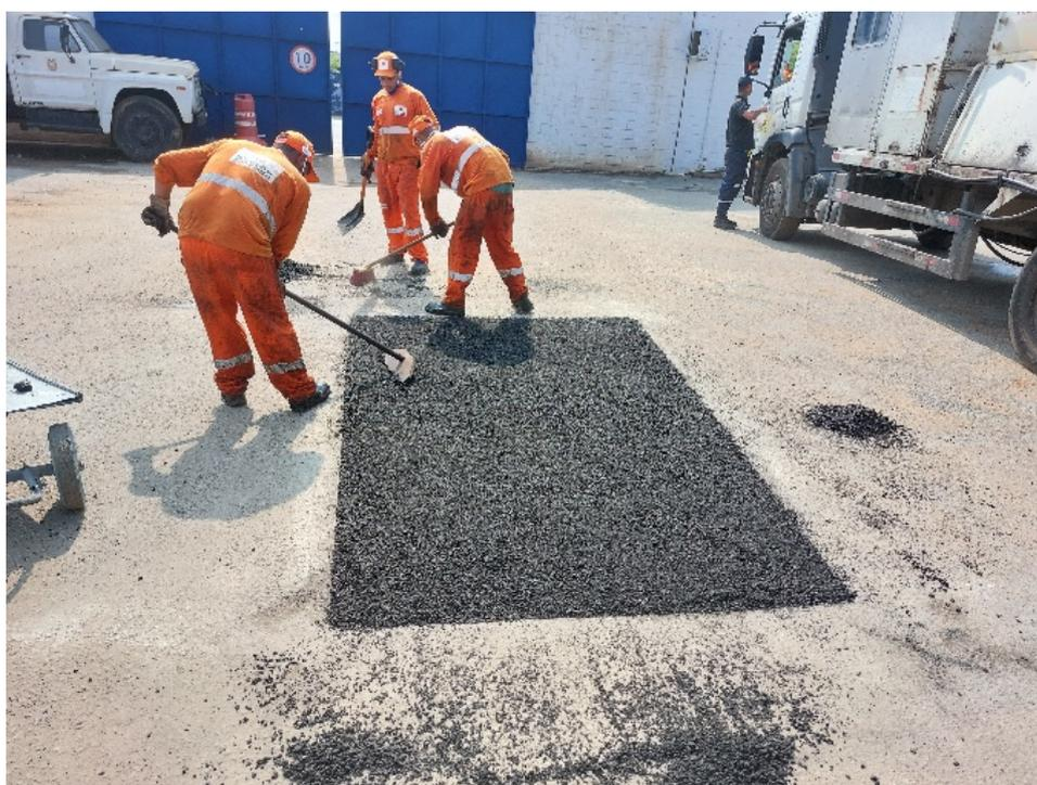
Figura 5 - Aplicação de mistura asfáltica beneficiada a frio com o aditivo B.
