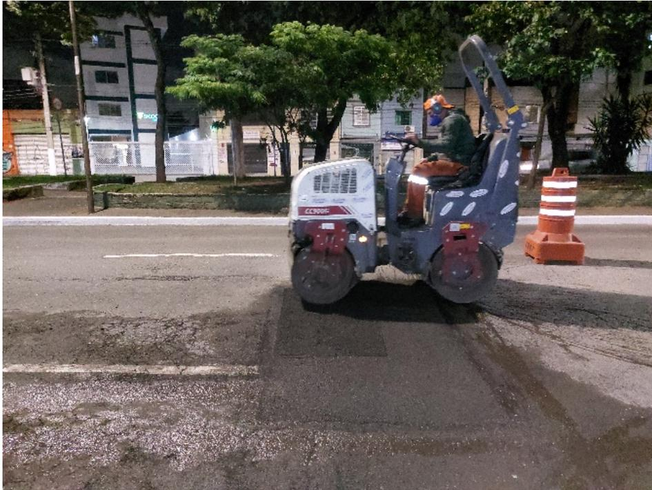
Figura 3 - Compactação com rolo compactador vibratório.
