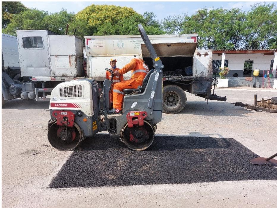
Figura 6 - Compactação com rolo compactador vibratório.
