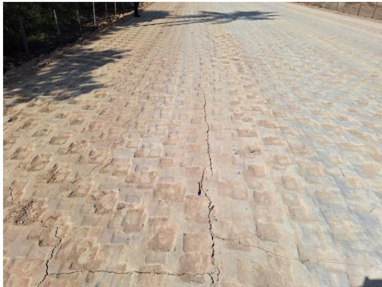
Figura 9. Trincas apresentadas na camada de um solo LG' entre as estacas 78 e 108. (AUTOR, 2024).
