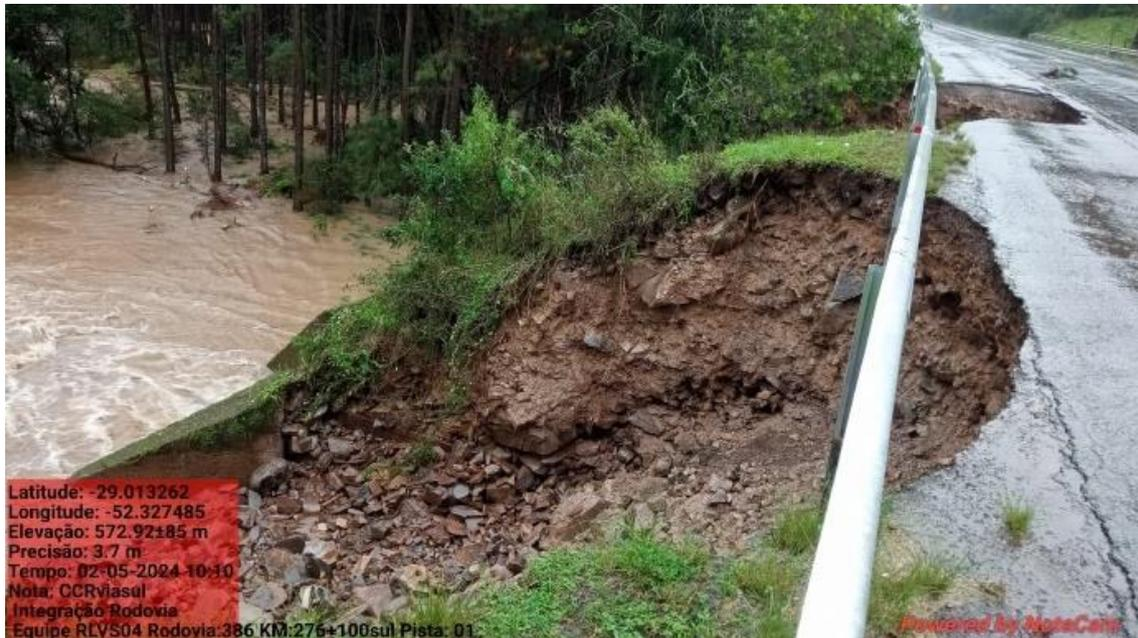
Figura 11. Ruptura de talude no km 276 da rodovia BR-386
