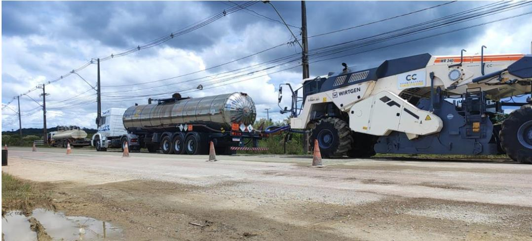
Figura 3. Comboio de execução de reciclagem profunda utilizado na rua Nicola Pellanda
