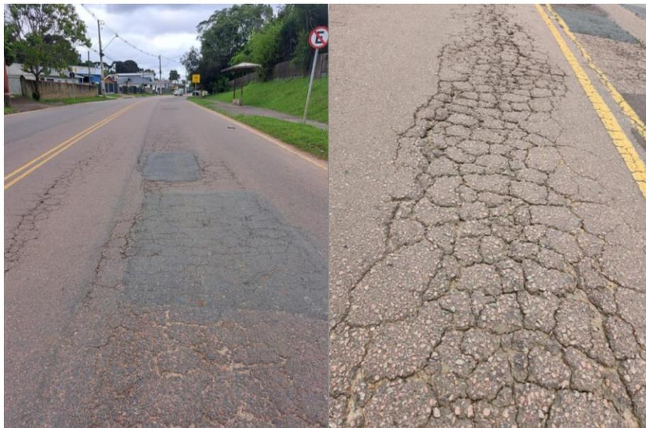
Figura 1. a) Visão geral do pavimento da rua Nicolla Pellanda; b) Realce para as trincas interligadas tipo couro-de-jacaré encontrados na Rua Nicola Pellanda
