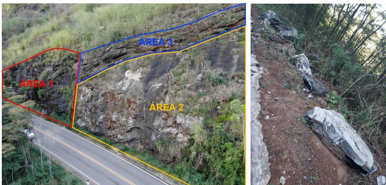
Figura 1. Aspectos gerais do talude rochoso, com a delimitação das áreas em função do grau de fraturamento (ADAPTADO DE GEOPHI ENGENHARIA, 2023).
