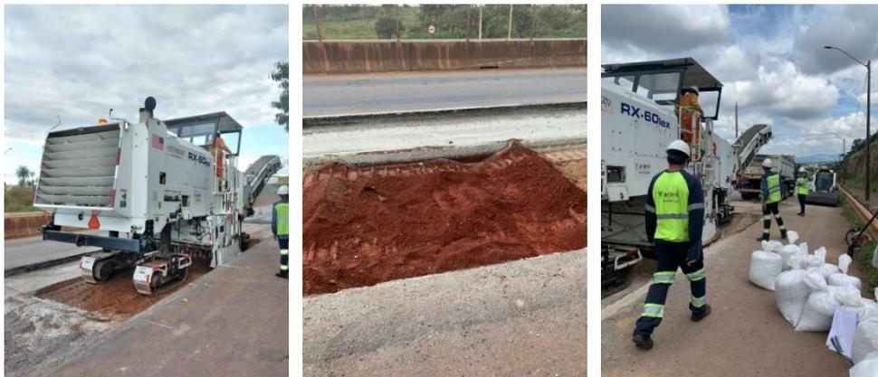
Figura 2 – Sondagens realizadas com a fresadora
