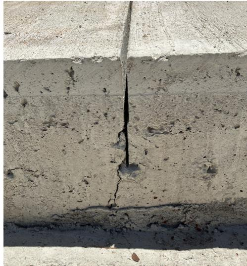
Figura 9 – Detalhe do corte da junta.
