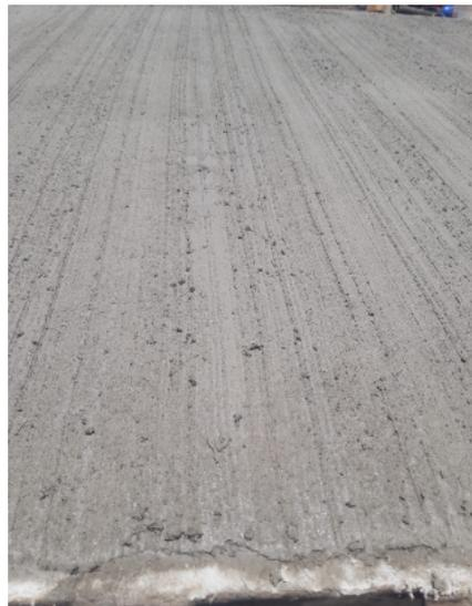
Figura 8 – Aspecto do pavimento após finalização do vassouramento.
