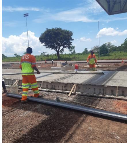
Figura 7 – Momento do vassouramento em uma parte do pavimento.
