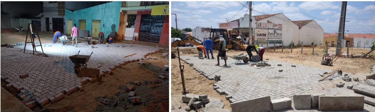
Figura 5. Transporte e assentamento dos blocos (AUTORES, 2024)
