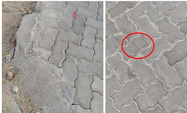
Figura 7. Falhas observadas na inspeção final (AUTORES, 2024)
