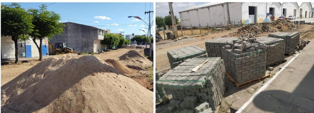
Figura 3. Armazenamento da areia e dos blocos (AUTORES, 2024)
