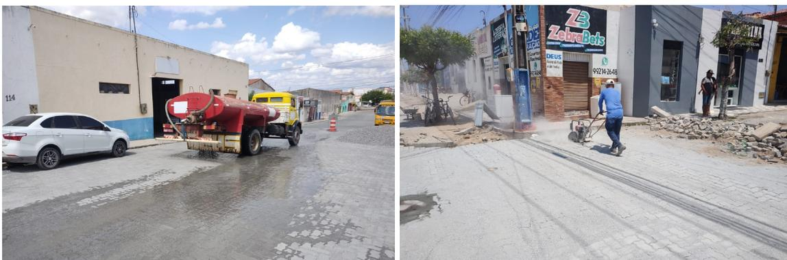
Figura 6. Umedecimento e compactação final do trecho (AUTORES, 2024)
