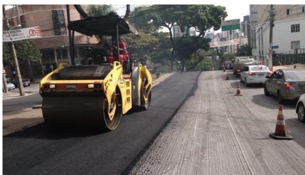
Figura 05. Aplicação do SMA (SUDECAP, 2020)
