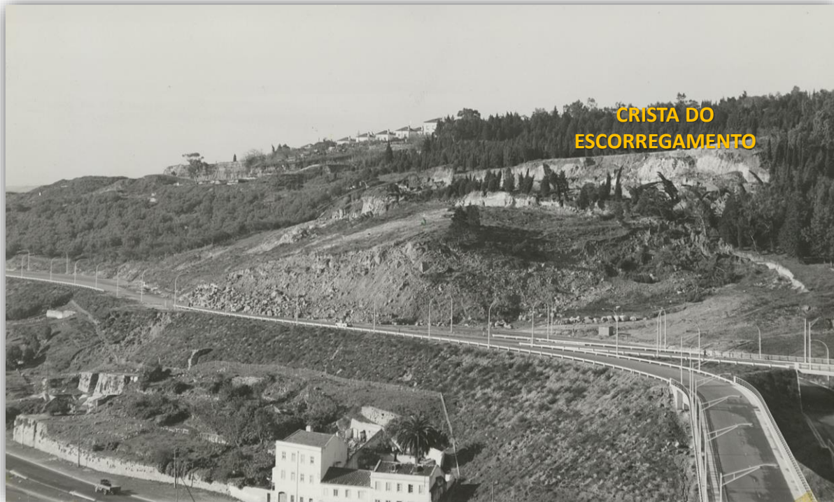
ESCORREGAMENTO DA ENCOSTA DO LADO DIREITO – junho de 1968
