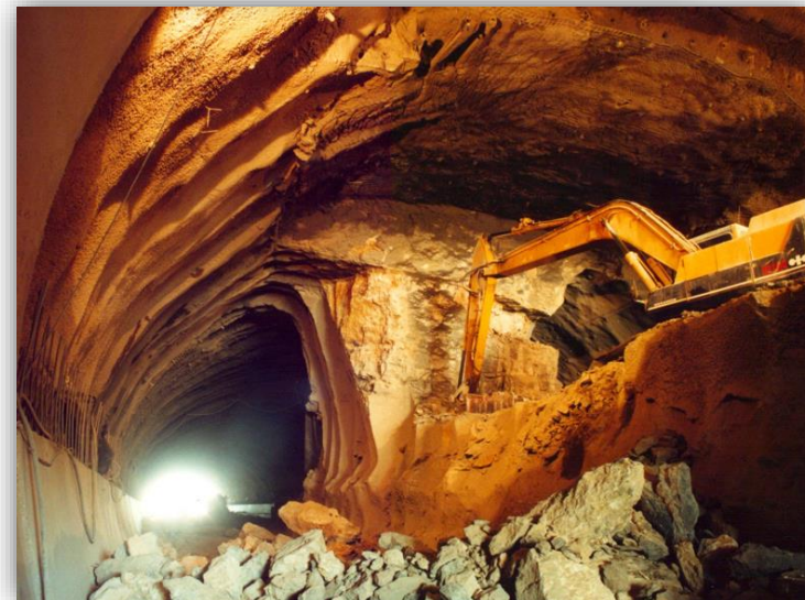
Aspetos do faseamento da escavação
