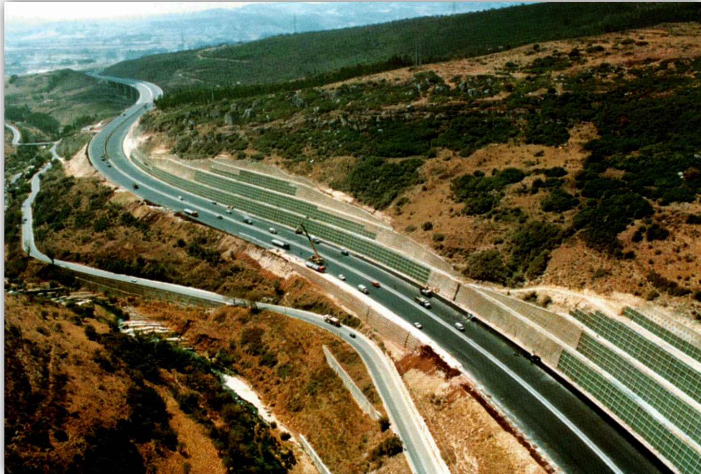
CORTINA DE CONTENÇÃO - CONCRETO PROJETADO E GRELHA DE ELEMENTOS PRÉ-MOLDADOS
