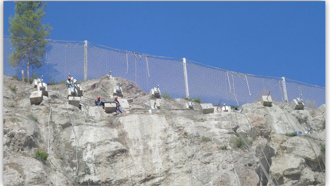
Estabilização ativa de blocos de grandes dimensões
