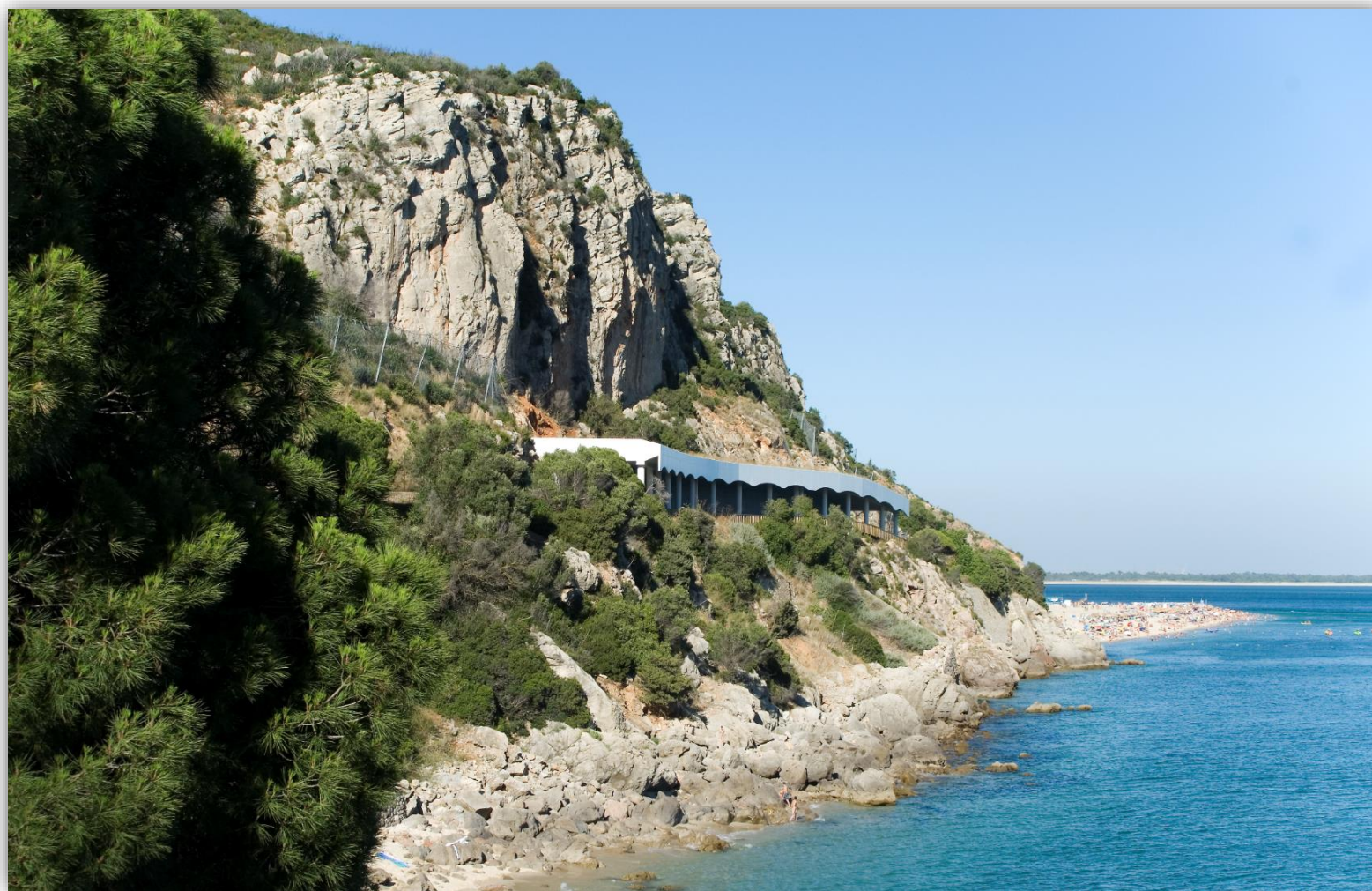
Falso túnel sob escarpa rochosa vertical de grande altura
