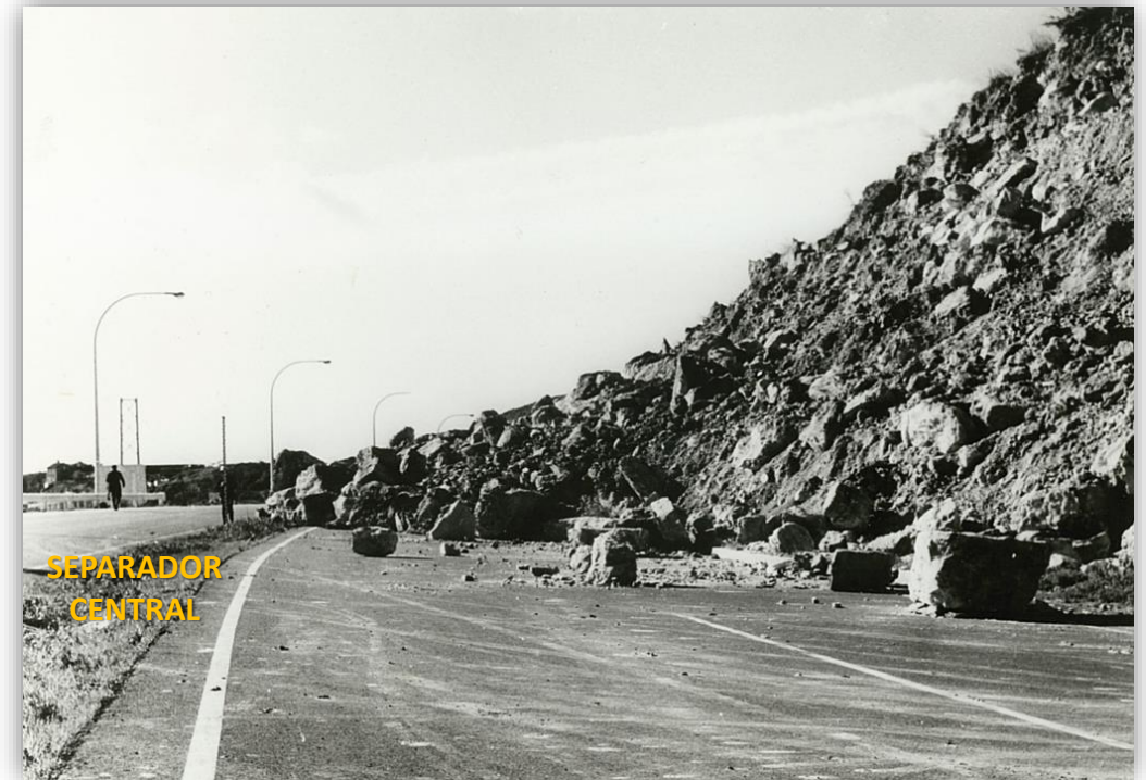
ESCORREGAMENTO DA ENCOSTA DO LADO DIREITO – junho de 1968
