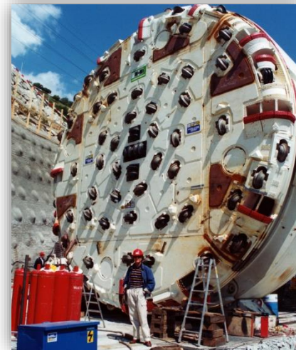
Túnel Lötschberg em construção (1999-2007) (EXTENÇÃO: 34,5 Km COTA: 800 m)
