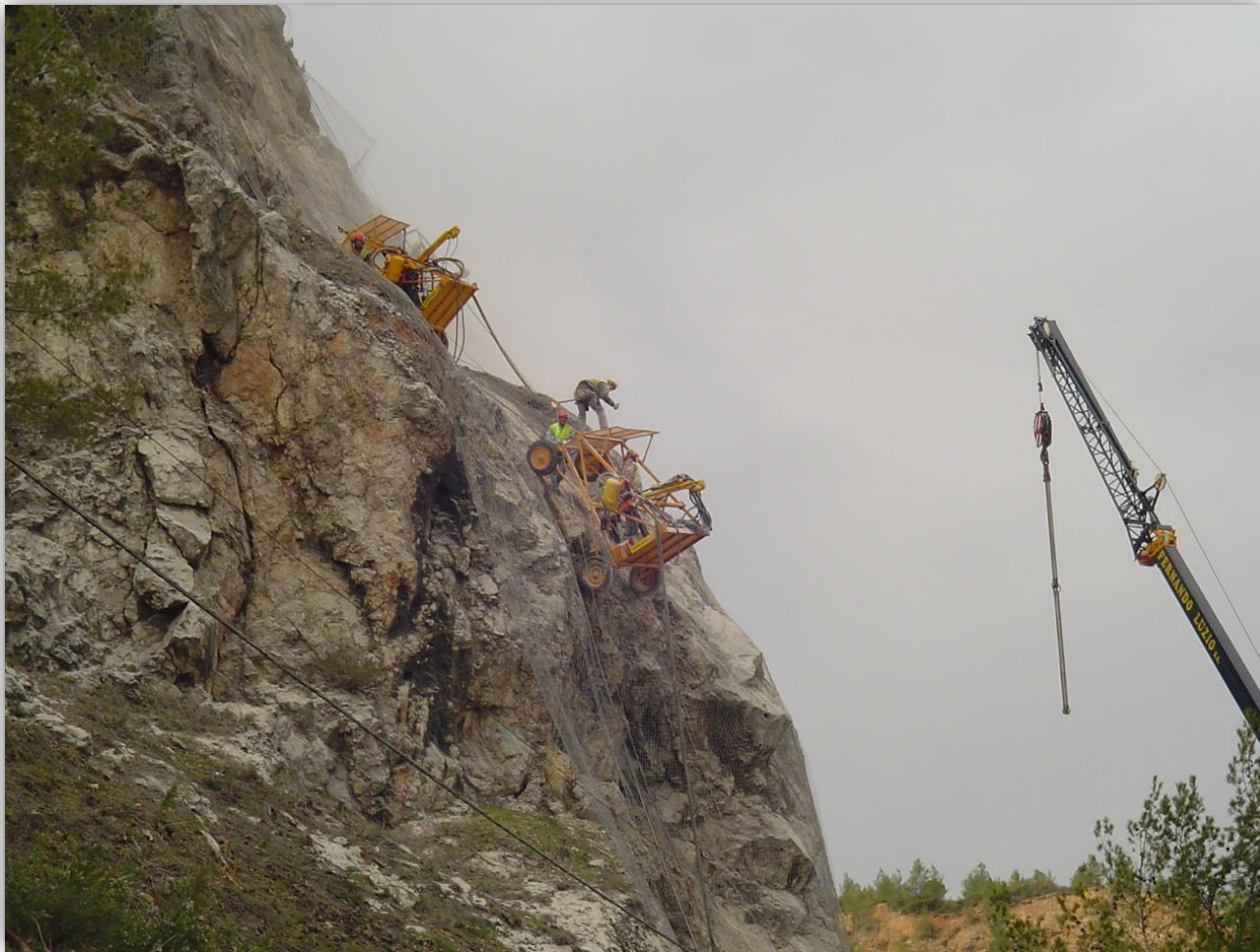
Rede metálica reforçada com pregagens
