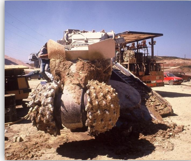
Escavação com máquina de ataque pontal
