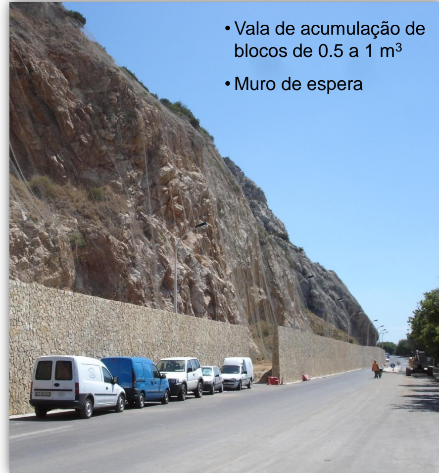
Rede metálica pregada no topo
