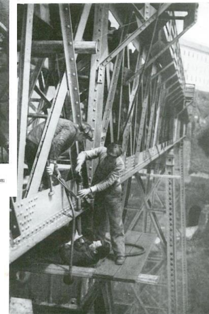
A 60 metros de altura, o pessoal do Serviço de Obras Metálicas trabalha tão natural e confiantemente na Ponte Maria Pia, como se estivesse dentro de uma oficina
