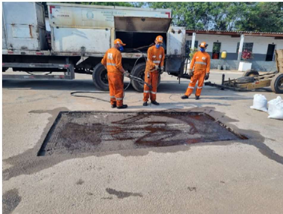
Figura 4 - Execução da pintura de ligação para realização do reparo com a mistura asfáltica com o aditivo B.
