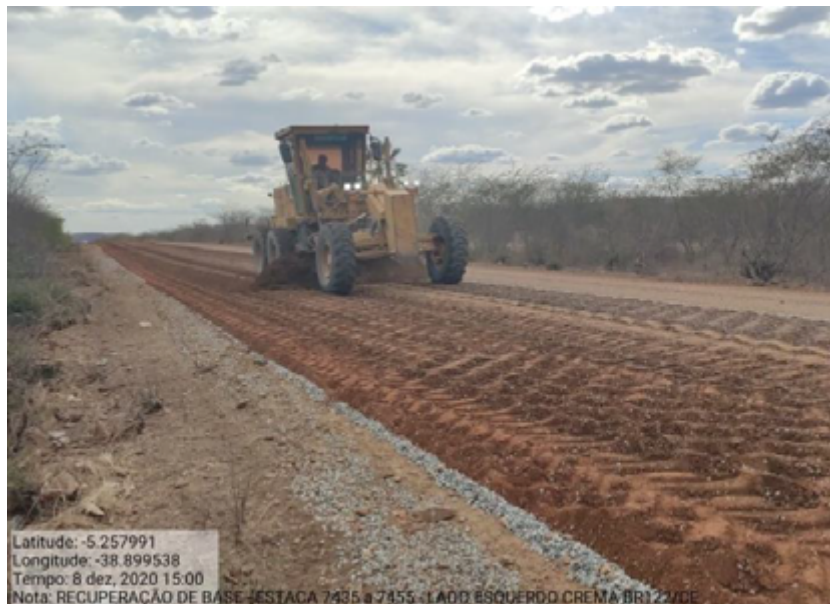
Figura 10. Execução de reciclagem de base (AUTOR, 2021)
