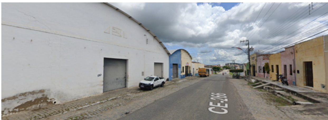
(a) Trecho antes do serviço de pavimentação com blocos de concreto intertravados
