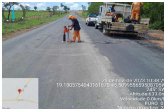
Figura 3. Coleta de corpos de prova na Rodovia (OS AUTORES, 2023)
