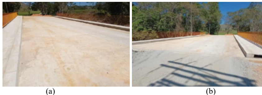
Figura 9. (a) e (b) Tabuleiro, guarda-corpos e calçadas em ótimas condições, elementos sem danos e sem desgaste. (DER-ES, 2024)
