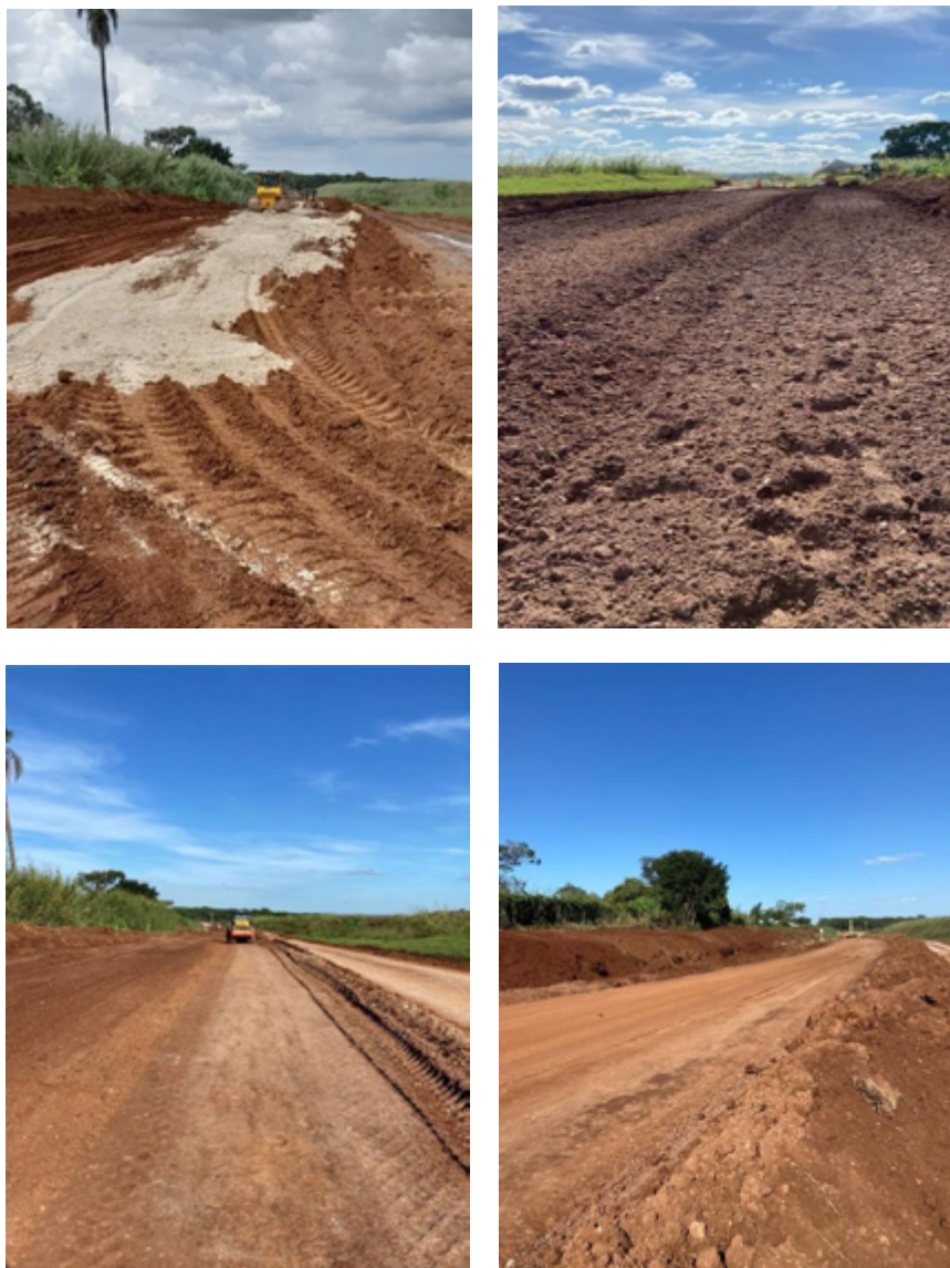
Figura 3: Etapas do processo de pavimentação (MOSAIC, 2023)
