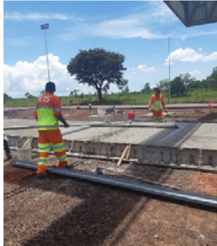
Figura 7 – Momento do vassouramento em uma parte do pavimento.
