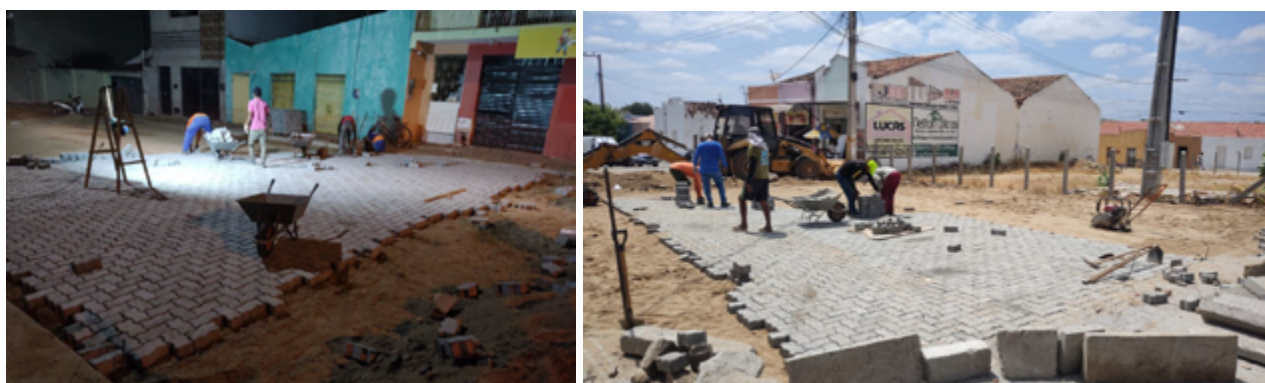
Figura 5. Transporte e assentamento dos blocos (AUTORES, 2024)
