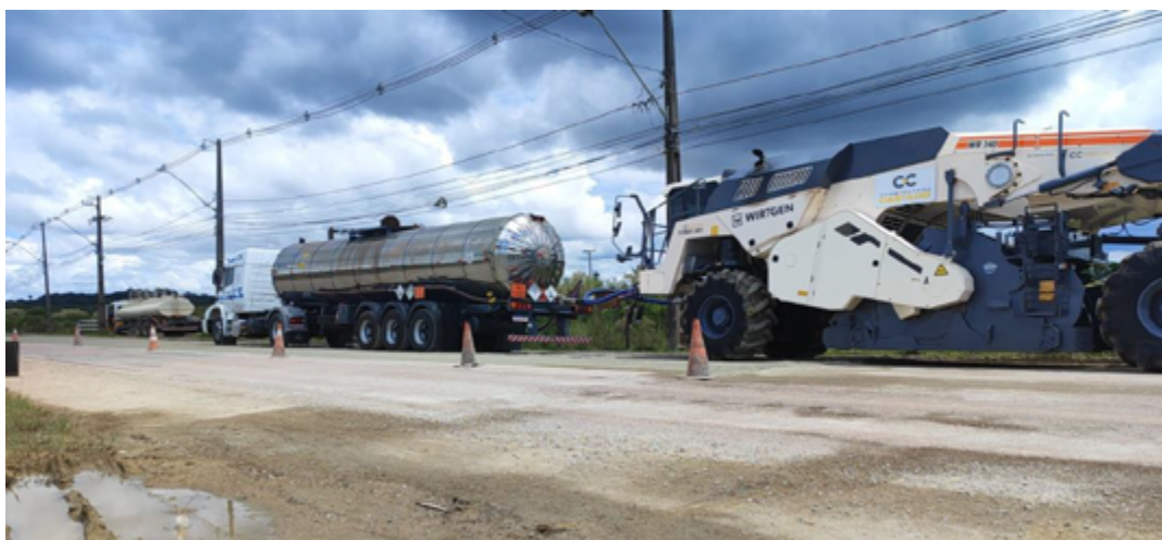
Figura 3. Comboio de execução de reciclagem profunda utilizado na rua Nicola Pellanda
