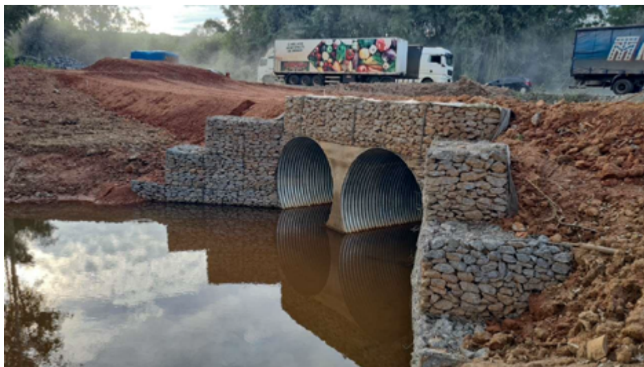
Figura 6: Obra em andamento na CMG-267 (DER-MG, 2024)
