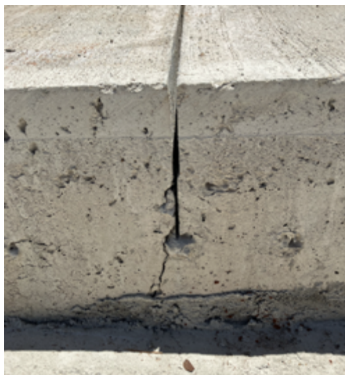
Figura 9 – Detalhe do corte da junta.
