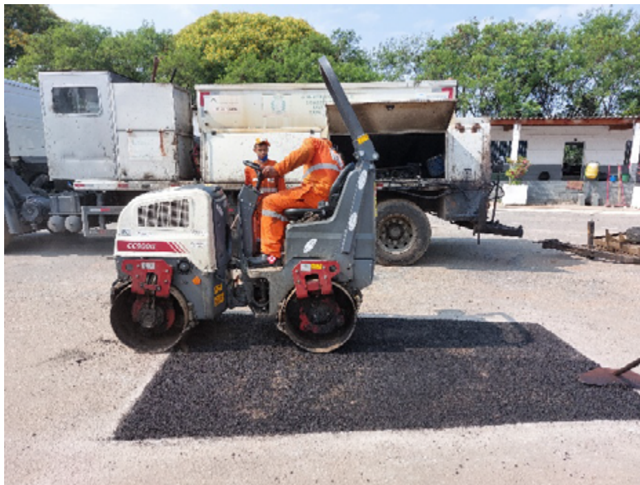
Figura 6 - Compactação com rolo compactador vibratório.
