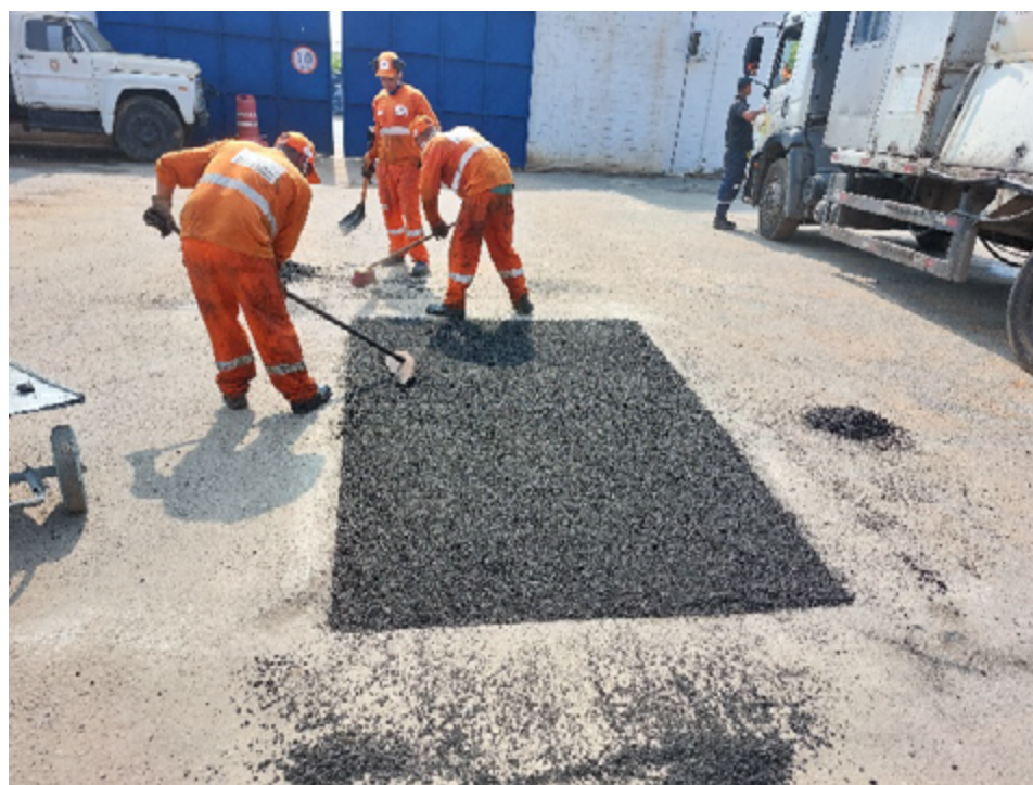
Figura 5 - Aplicação de mistura asfáltica beneficiada a frio com o aditivo B.
