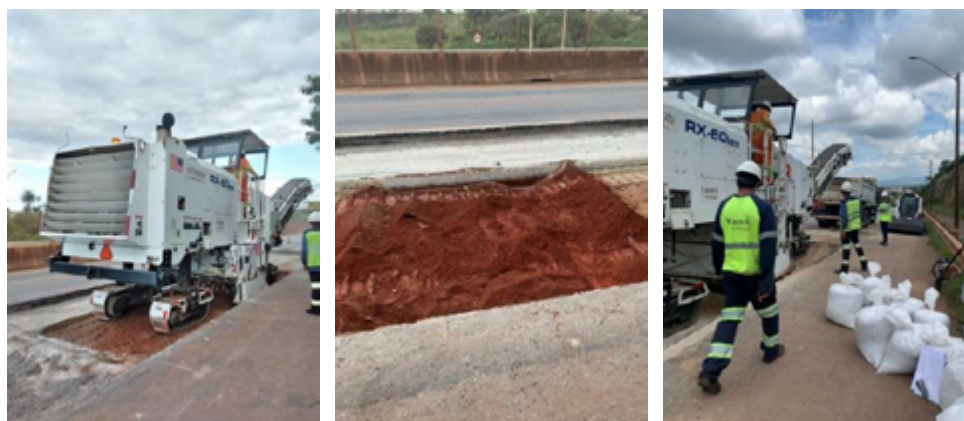
Figura 2 – Sondagens realizadas com a fresadora
