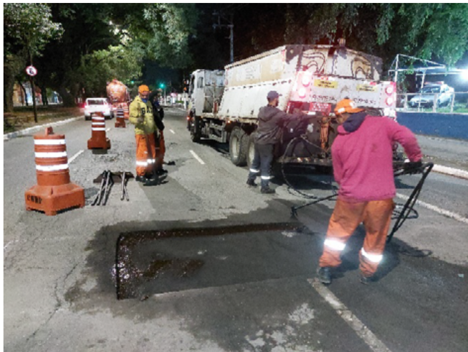
Figura 1 - Execução da pintura de ligação para realização do reparo com a mistura asfáltica com o aditivo A.
