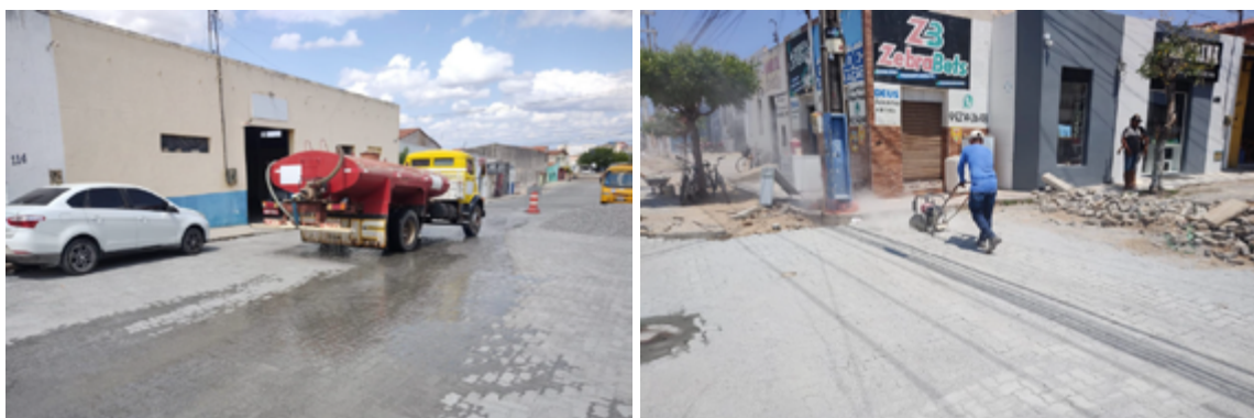
Figura 6. Umedecimento e compactação final do trecho (AUTORES, 2024)
