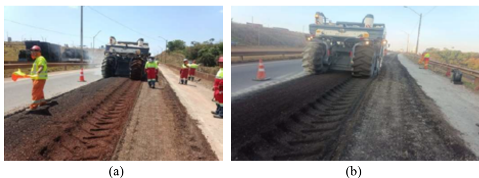
Figura 5 - (a) trecho com a emulsão com aspecto heterogêneo; (b) Trecho com a emulsão com aspecto homogêneo
