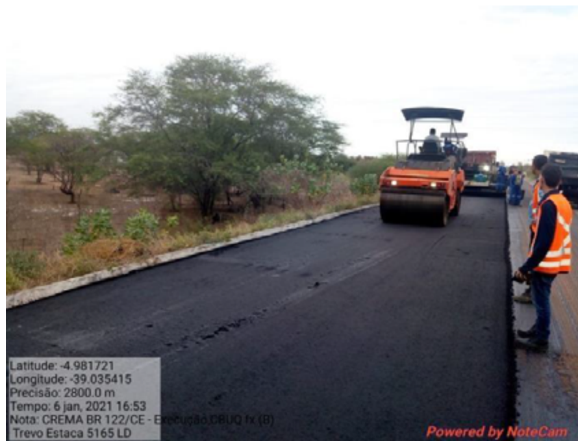
Figura 8. Execução de CBUQ (AUTOR, 2021)
