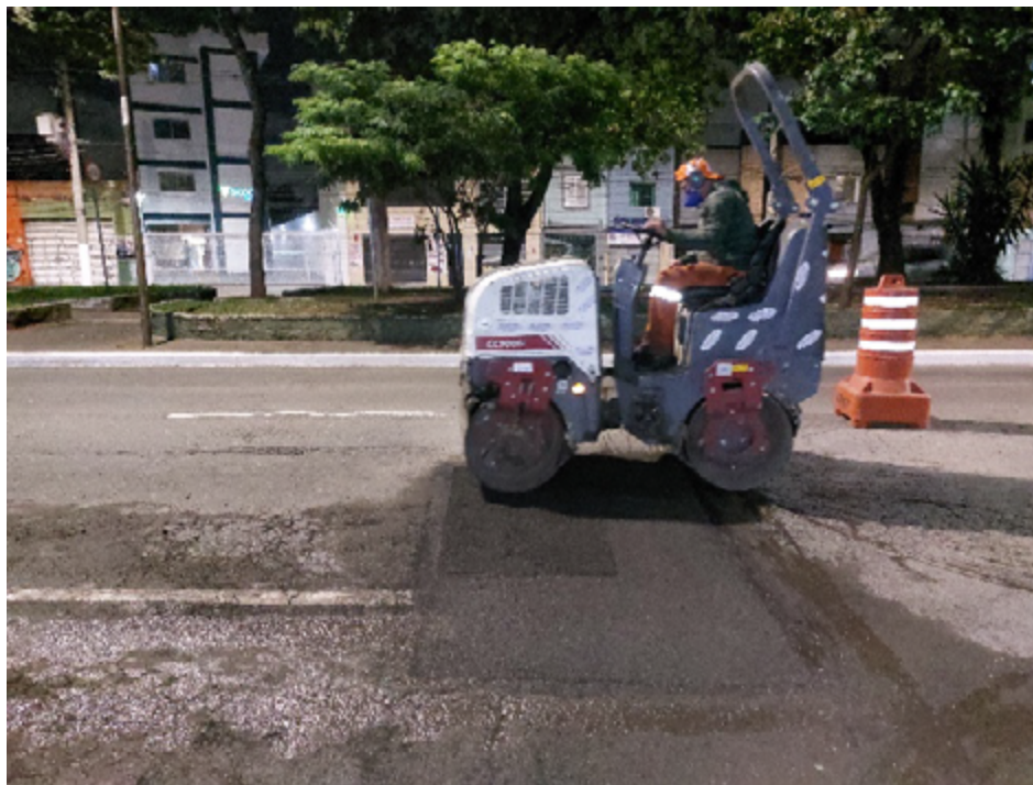
Figura 3 - Compactação com rolo compactador vibratório.
