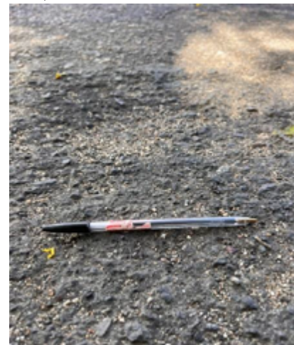
d) afundamento consolidado local
