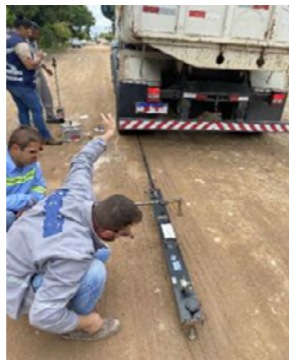
Figura 2. Realização dos ensaios de LWD e VB (AUTORES, 2023)
