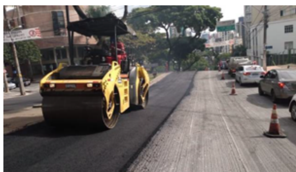
Figura 05. Aplicação do SMA (SUDECAP, 2020)
