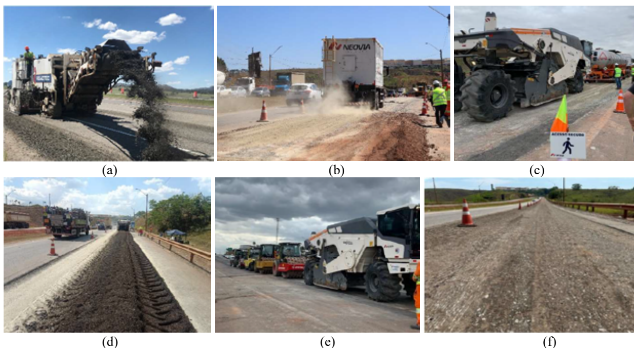
Figura 3 - (a) Fresagem superficial do CAUQ; (b) Espalhamento do cimento; (c) Comboio Tanque Emulsão e Recicladora; (d) Aspecto trecho após a passagem da Recicladora; (e) Comboio Rolos Compactadores; (f) Aspecto final camada reciclada
