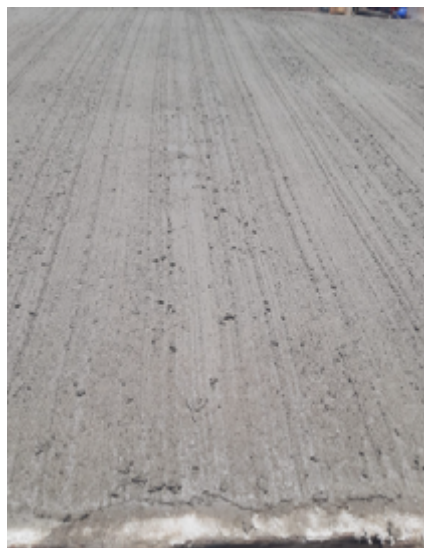
Figura 8 – Aspecto do pavimento após finalização do vassouramento.
