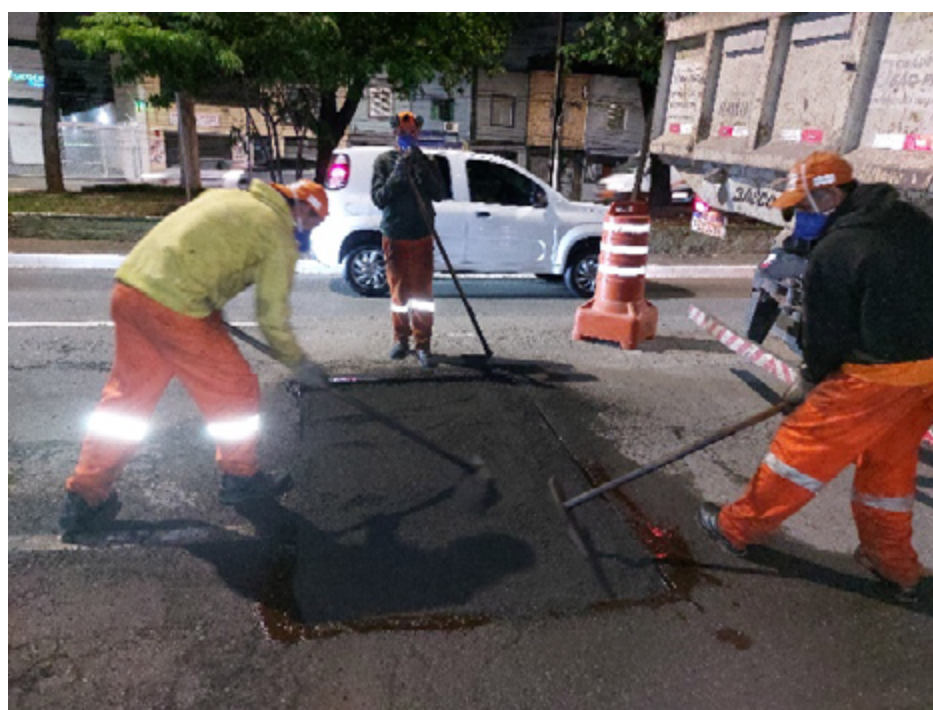
Figura 2 - Aplicação de mistura asfáltica beneficiada a frio com com o aditivo A.
