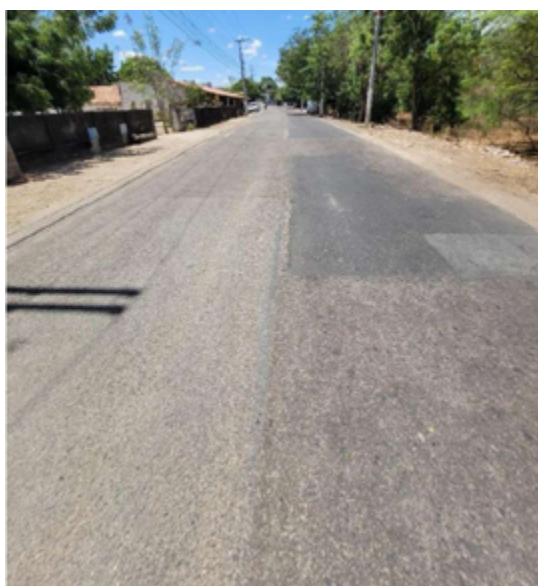
Figura 3 – Vista panorâmica do trecho
