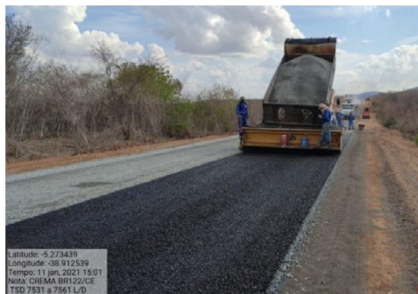
Figura 9. Execução de TSD (AUTOR, 2021)
