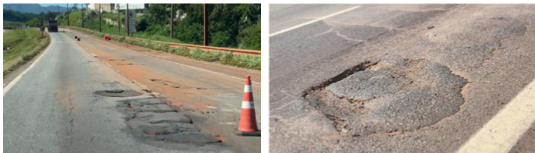
Figura 1 – Trecho Experimental do Contorno de Betim antes da obra de reciclagem
