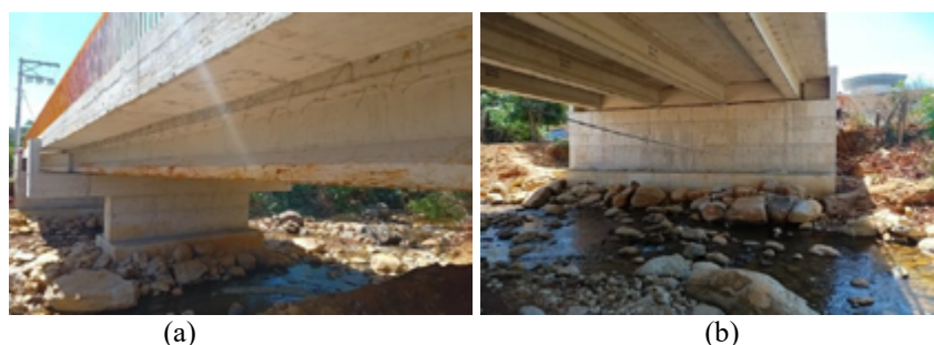
Figura 10. (a) Viga moldada in loco sem indícios de deslocamento do concreto, nichos de concretagem, oxidação de armaduras ou outras patologias; (b) Encontros sem danos, com enrocamento de proteção para evitar erosão dos materiais devido a correnteza. (DER-ES, 2024)
