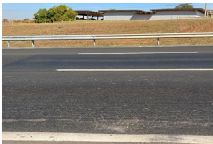
Figura 5 – Trincamentos do tipo FC-3
